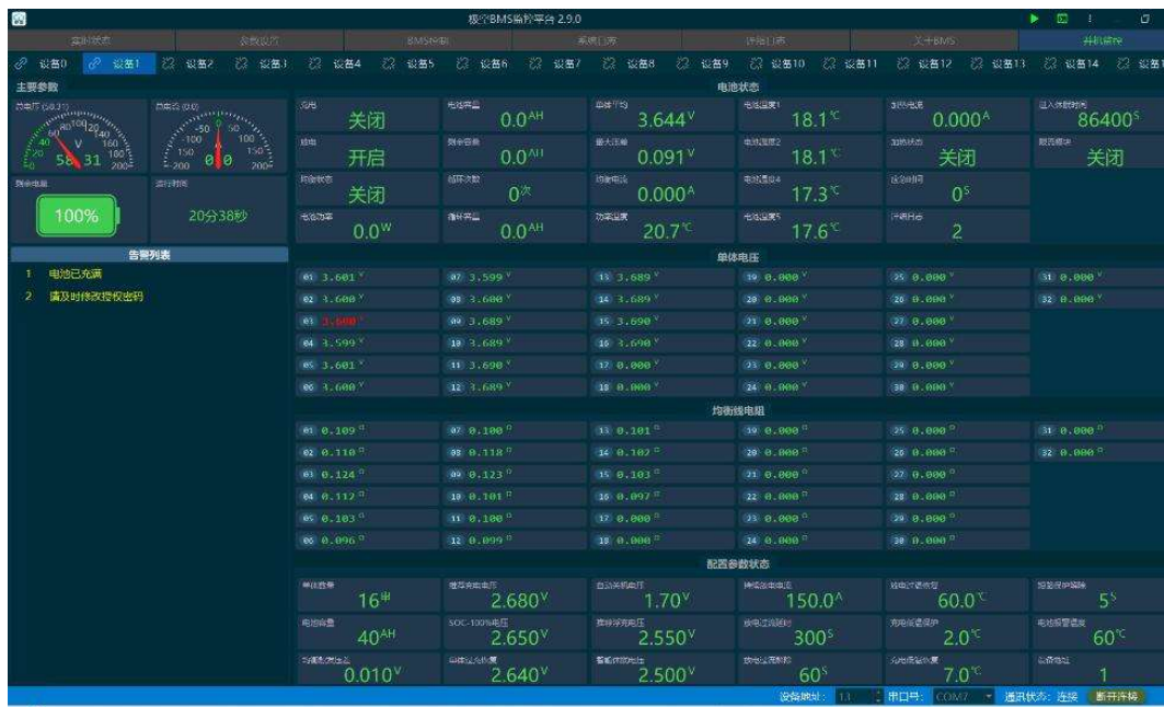
Widok monitorowania BMS nr 2
